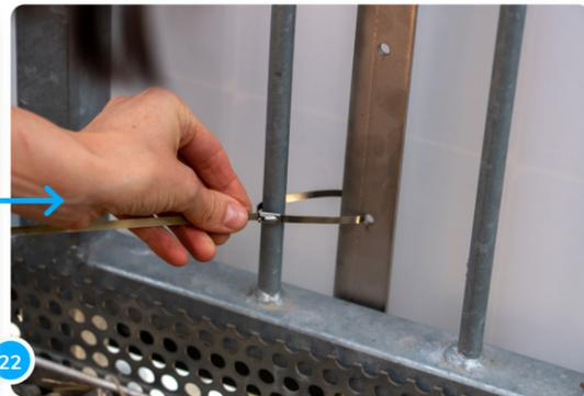
Ahora puedes pasar los sujetacables alrededor del extremo inferior de los ganchos para balcones. Ajusta los sujetacables firmemente para que el panel no pueda oscilar.
