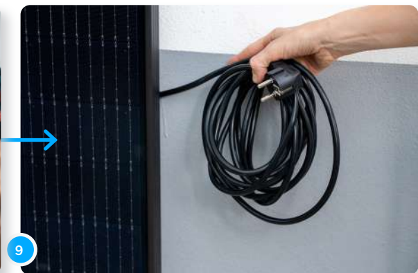
Asegúrate de sacar el cable de alimentación por detrás antes de fijar los paneles, para que esté accesible para enchufar más tarde.
