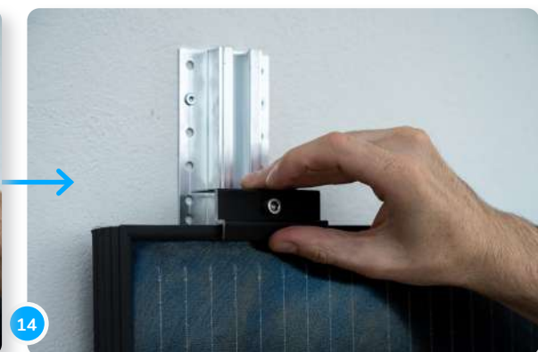
Colocar la guía en posición...
