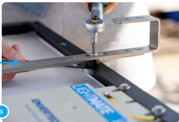
Por favor, fija los ganchos al panel con los tornillos y las tuercas de seguridad. Presta atención al torque correcto (según las instrucciones) mientras lo haces.
