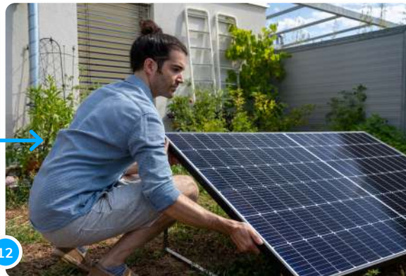
12 ... o puedes fijar el panel utilizando cuatro losas de concreto por cada soporte como contrapeso...
