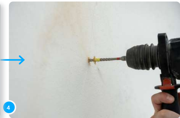
Perfora ahora agujeros en los lugares previstos con una broca adecuada...
