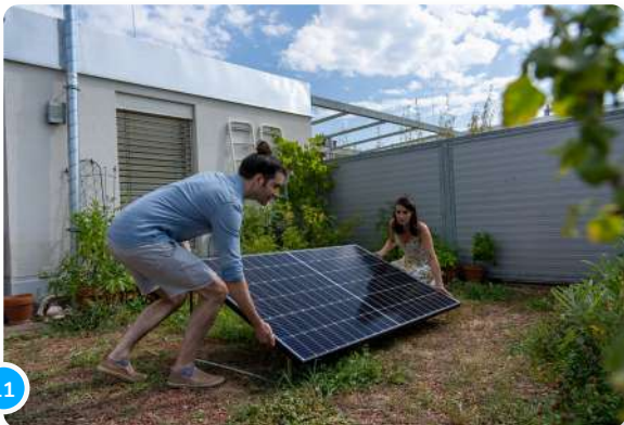
11 Una vez que hayas encontrado un lugar adecuado, puedes sujetar el panel al suelo con tornillos...
