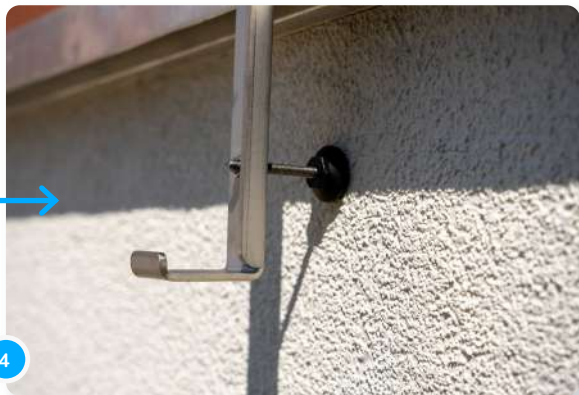
Para ello, atornilla el separador en uno de los tres orificios inferiores para alinear la posición del panel.
